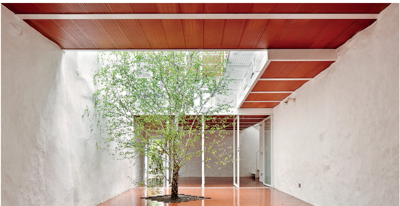
Figura 3. Instalación de tablero sobre vigueta metálica
